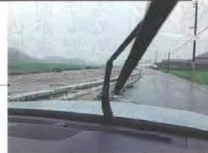
7月6日13時30分頃— 高屋川、道路冠水
